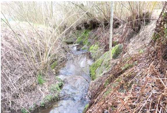
Abbildung 3: Trapezprofil im oberen, hart verbauten Abschnitt des Fonsbachs
