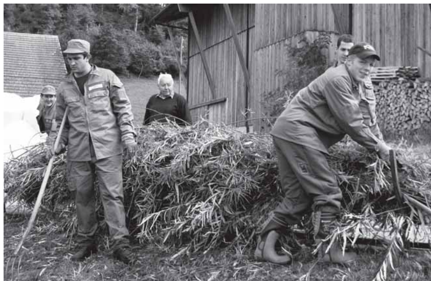
Unter dem wachsamen Auge von Schwellenmeister Hans Schaffer werden oberhalb des Wasengrabens Faschinen gebunden. Foto ZSO
