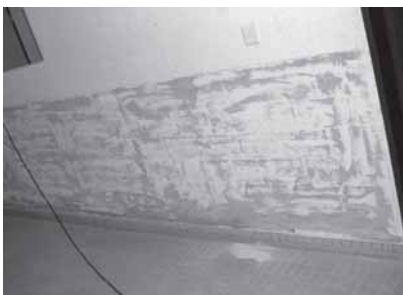
Sanierung der Garderoben in der Mezwan
