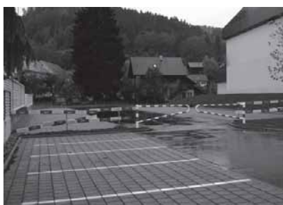
Neuer Parkplatz bei der Mezwan
