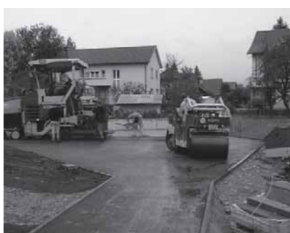
Neuer Parkplatz bei der Mezwan
