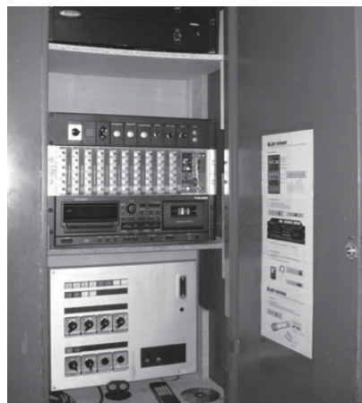
Erneuerung Beschallungsanlage Mezwan
