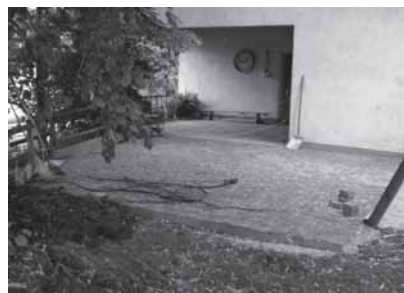
Erstellen von festen Belägen beim Kindergarten Badmatte.
