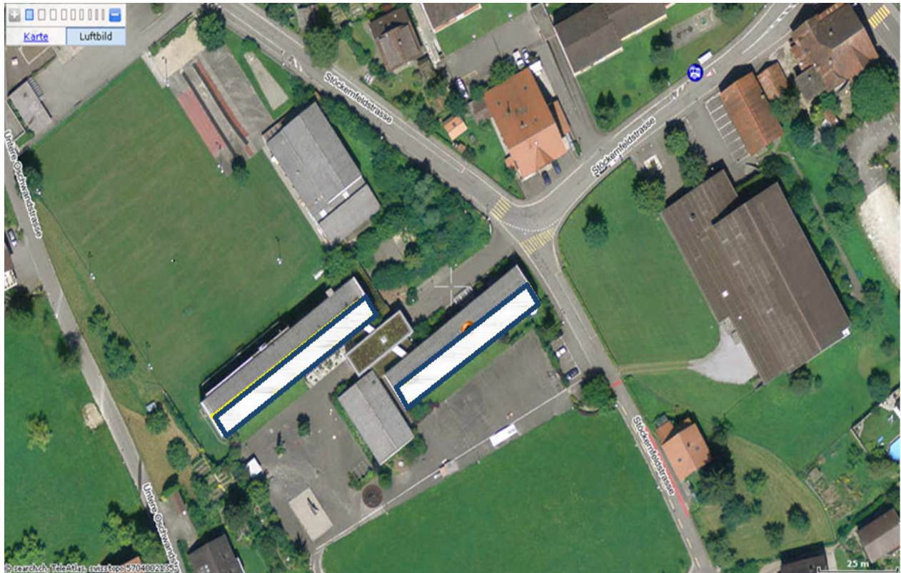
Dachseiten Süd/Ost Primar- und Sekundarschulhaus Stöckern
