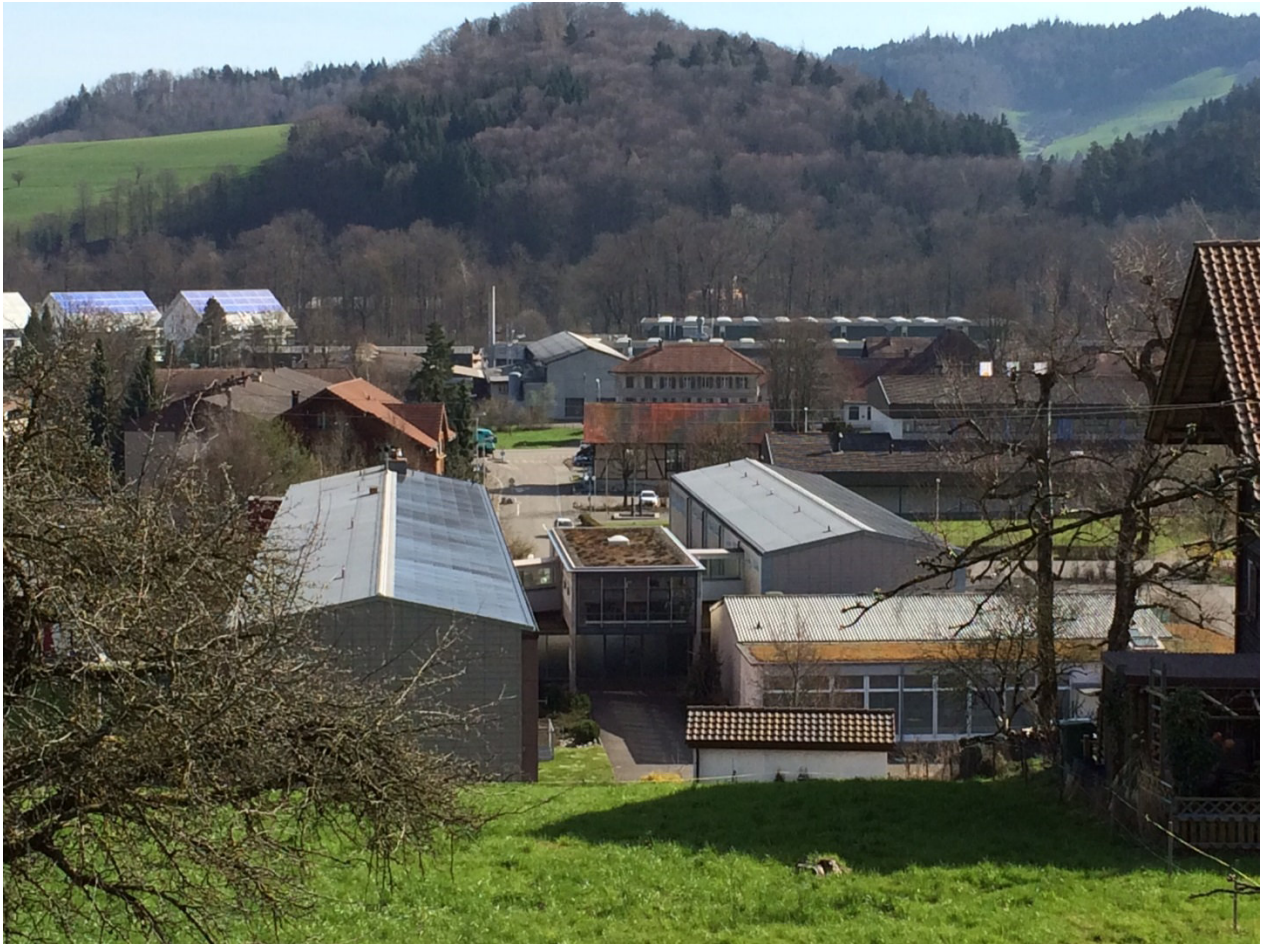
Foto der sanierten Dächer mit Fotovoltaikanlage
